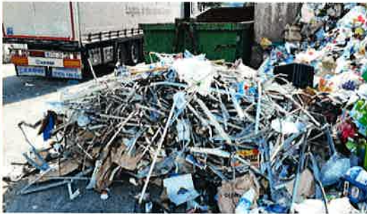
08/06/2018 - Ferrailles de chantier
